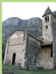
Attuale sacello che fungeva da coro alla chiesa del '400
